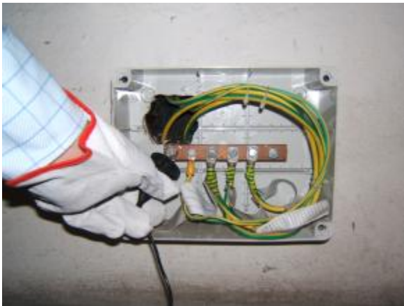
Između glavnog potencijala (MEB) I na primer..... Glavne vodovodne cevi (Fig. 2 and 3)
